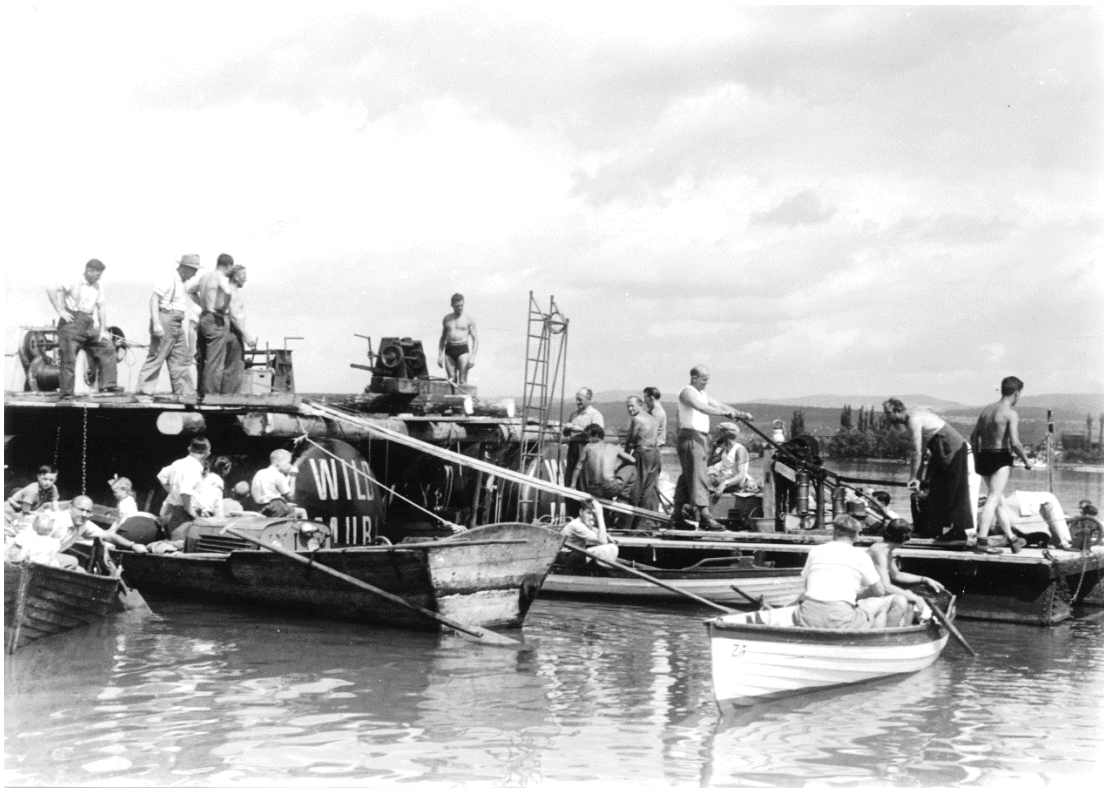
Floss mit Hebemannschaft, auf rechtem Floss Luftpumpe, von 2 Personen bedient (Foto Eugen Grau)
